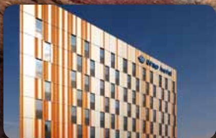
Etap Hotel Kop van Kessel, Leuven / Belgium
