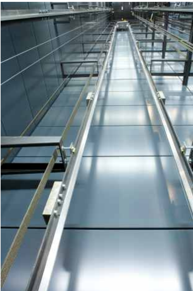
Revestimiento de ascensores - Cladding of elevator shaft
