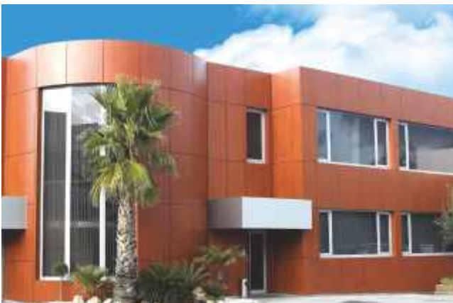
Oficinas, Lourosa (Portugal) - Offices Building, Lourosa (Portugal)
