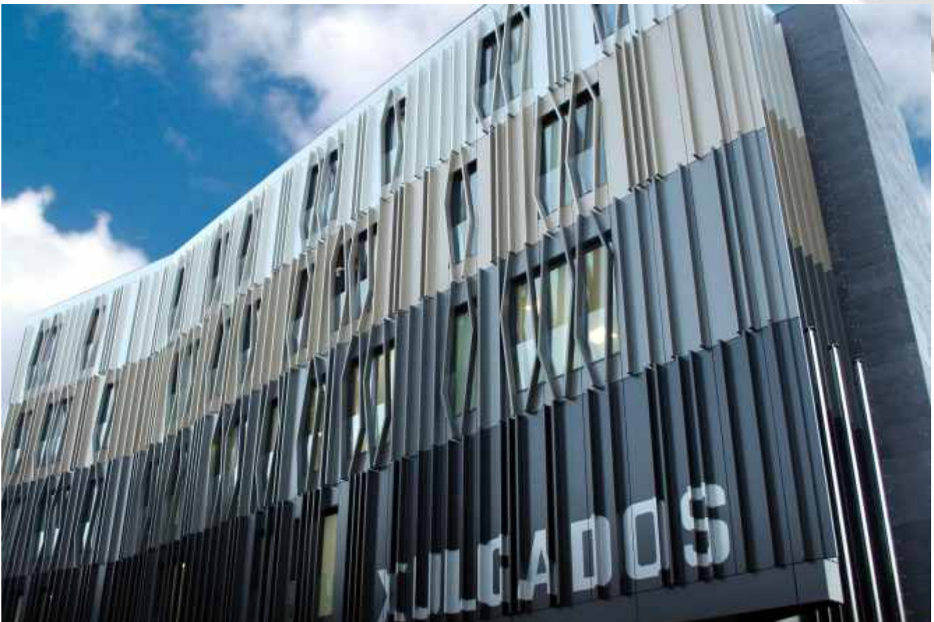
Juzgados, Barco de Valdeorras (Spain) - Courts, Barco de Valdeorras (Spain)
